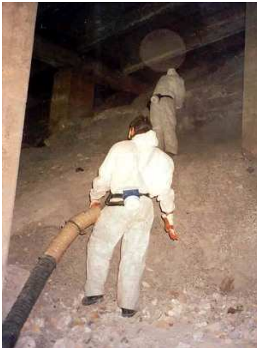
Sanierung der Zinkhalde im Stelzenhaus
