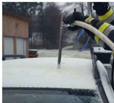
FogNail mit Zugang über das Autodach
